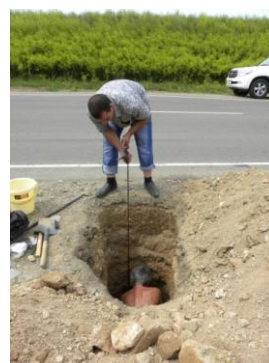
Рисунок 2 – Разработка шурфа на участке ПК3+00
