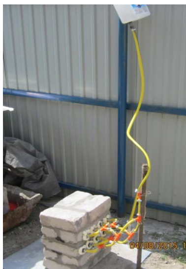
Рисунок 4 – Установка инъекционного оборудования
