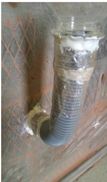
Рисунок 2 – Заделка стыков кладки и инъектора герметиком
