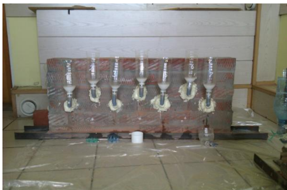
Рисунок 1 – Установка инъекторов в кладку из керамического кирпича
