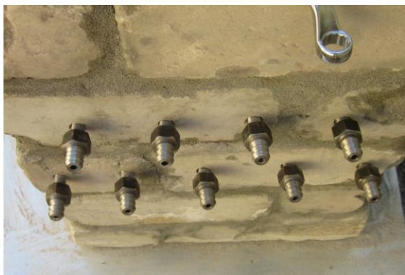
Рисунок 3 – Установка пакеров в кладку из силикатного кирпича
