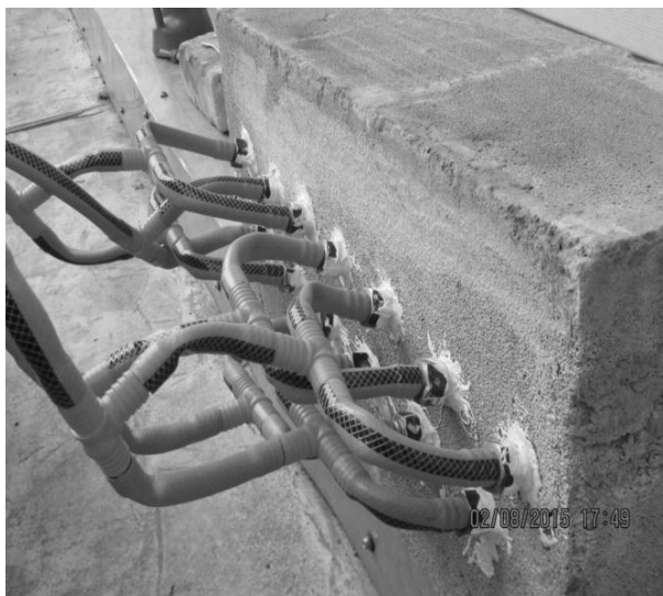
Рисунок 3 – Испытания по устройству объемной гидрофобизации
