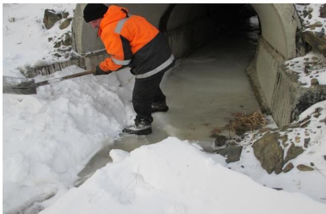
Рисунок 5 – Устройство водоотвода при оттаивании наледи горячей водой
