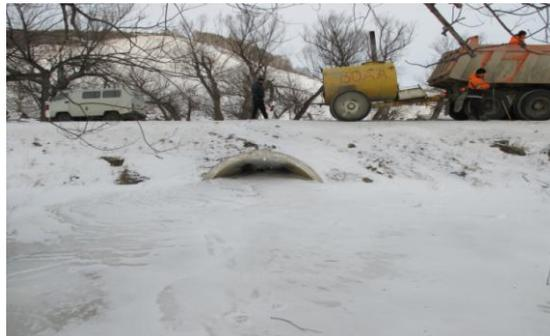
Рисунок 3 – Подвоз горячей воды к месту образовавшейся наледи
