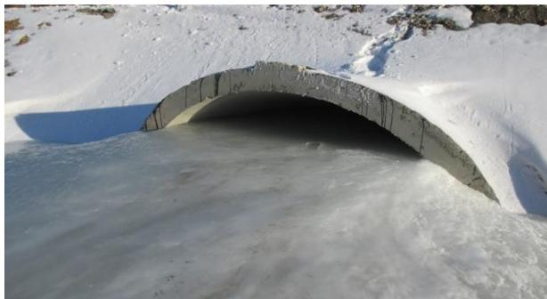
Рисунок 2 – Дефект «Появление снежно-ледяных отложений в теле трубы в период до начала весеннего паводка» автомобильной дороги «Чарышское – Тулата – Усть-Тулатинка»
