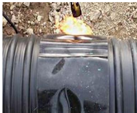
Рисунок 3 – Термоусаживающаяся муфта
