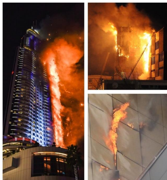
Рисунок 1 – Пожары навесных вентилируемых фасадов
