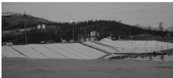
Рисунок 1 – Геомембрана гидротехнического сооружения
