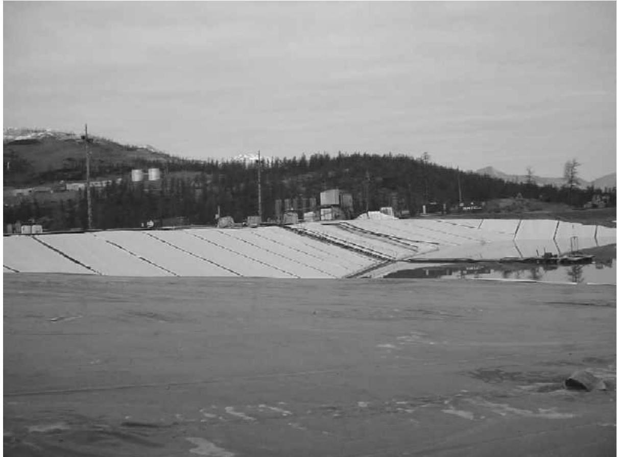
Рисунок 2 – Строительство водоема с использованием геомембраны в окрестностях Магадана
