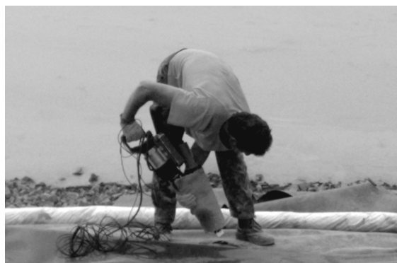
Рисунок 4 – Экструзионная сварка геомембраны
