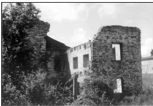
Рис. 3. Северный фасад производственного корпуса Павловского завода. Фото 2002 г.
