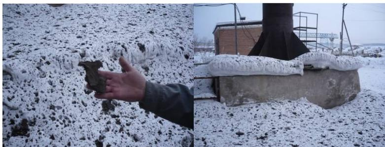
Рисунок 2 – Вынос несгоревшего топлива из дымовой трубы
