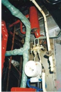
Рисунок 1 – Импульсная камера на котле ДЕ-6,5-14
